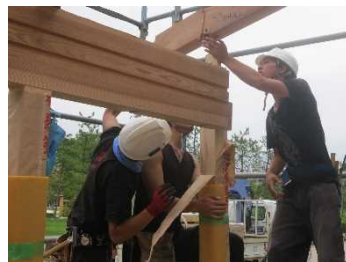
茶室「本丸亭」新築（富山市）：伝統的な木組み構法による木造建築
