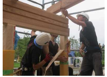
茶室「本丸亭」新築（富山市）：伝統的木組み構法による木造建築
