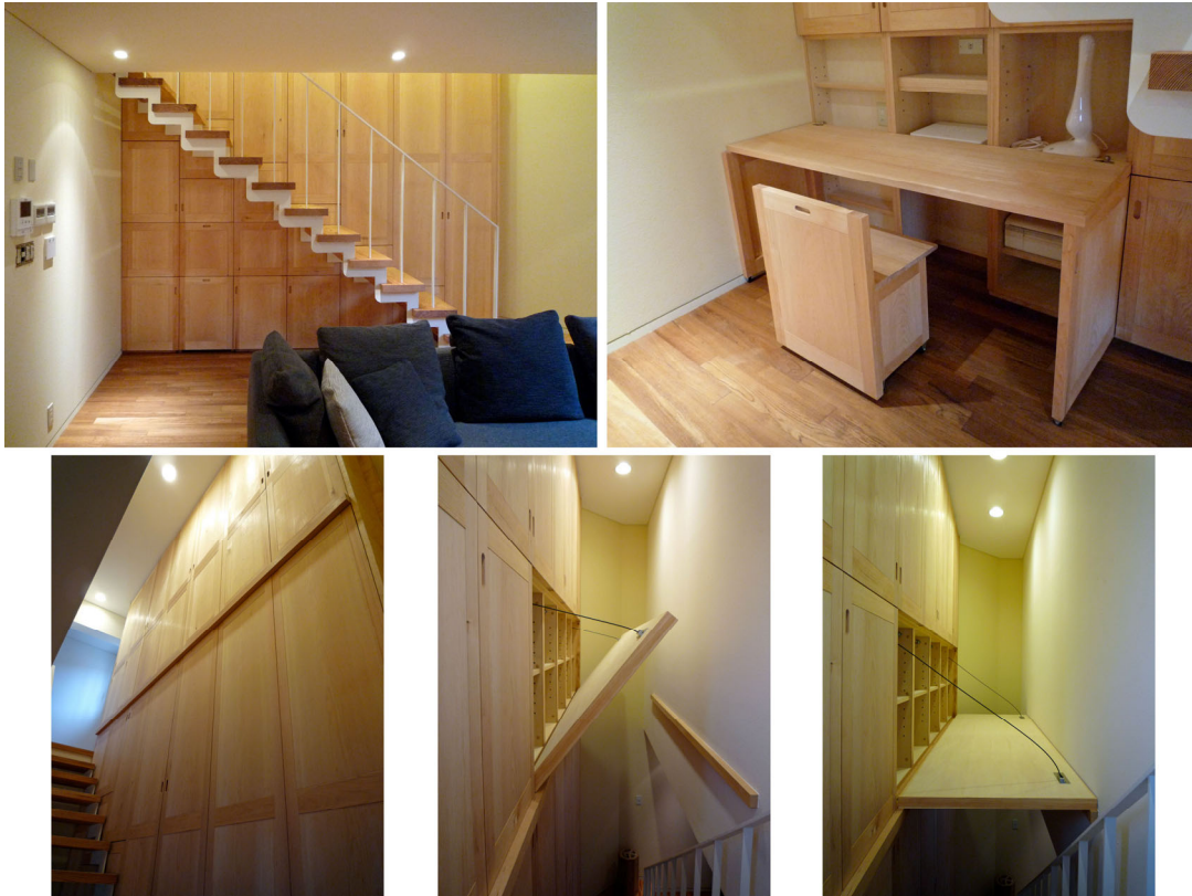
階段下部がPC用の作業スペースとなる。また吹抜上部の収納スペースは扉の一部が電動オペレータで開きステップとなる。
