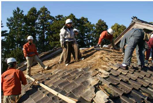
屋根瓦解体 (建築大工コース)
