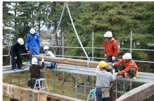
軸部組立て (建方)
