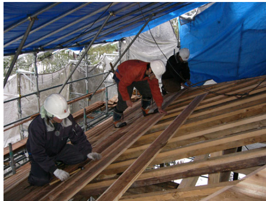
屋根野地板張り
