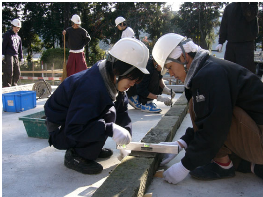
布基礎石据付け
