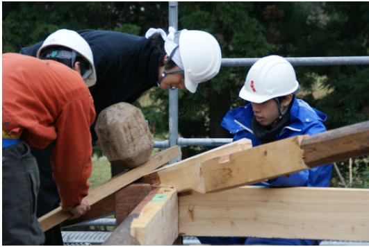
軸部組立て (建方)
