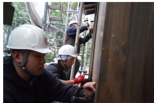
外部腰板張り
