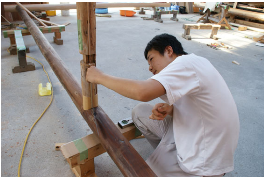
下屋底：柱と桁のひかり付け (古材)
